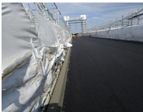
Etanchéité et enrobé de trottoir : terminés
