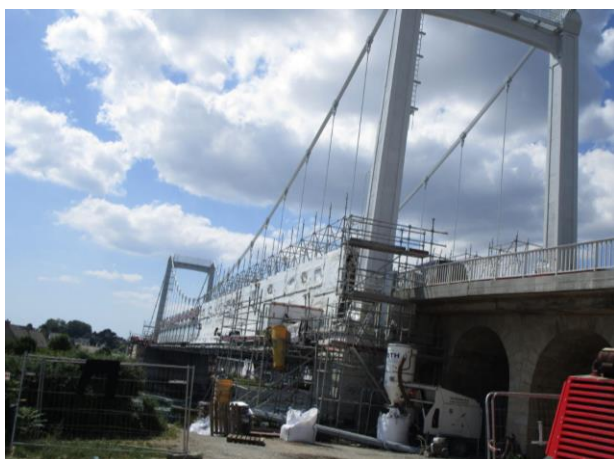
Echafaudages de suspension et de pylône démontés
