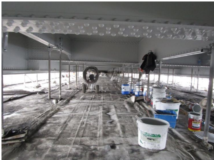
Peinture de la structure métallique du tablier : en cours
