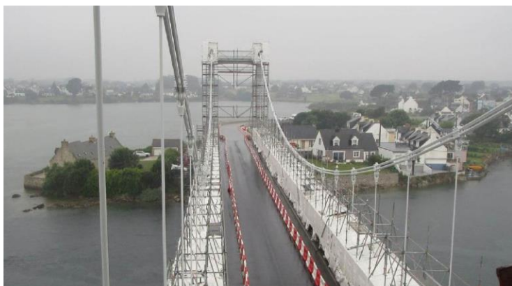
Suspentes changées et remise en peinture de la suspension terminée
