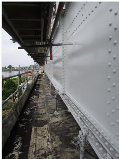
Peinture de la structure métallique du tablier : en cours
