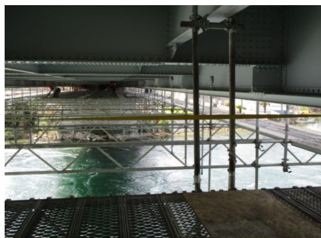
Echafaudages de tablier en cours de démontage
