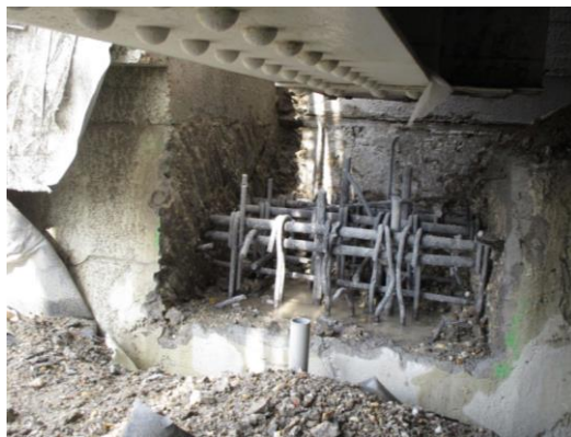
Changement des appareils d'appuis : en cours
